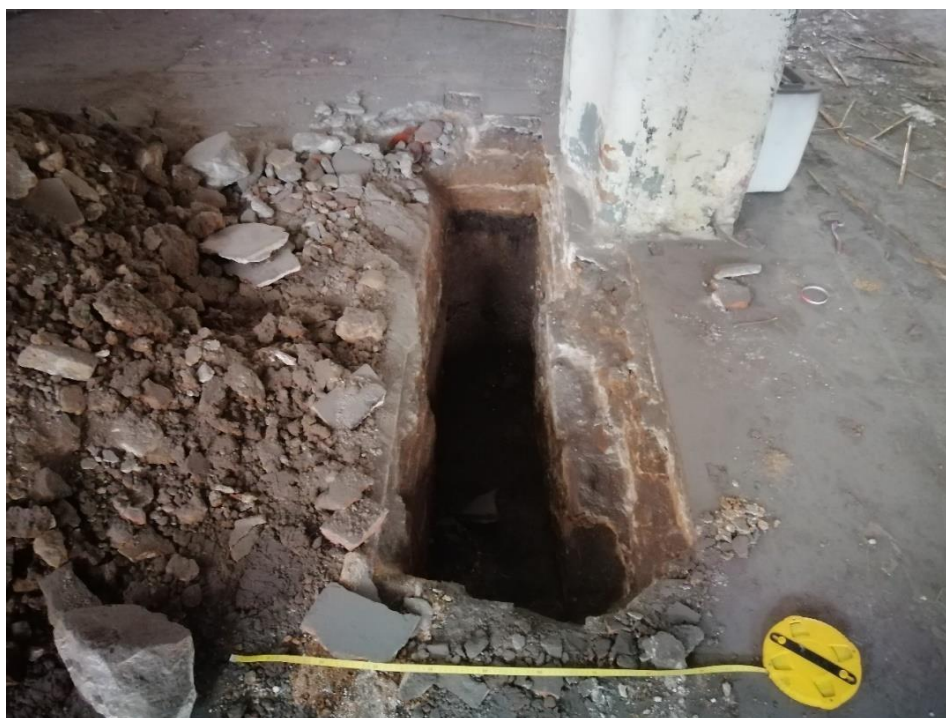
Fig.9. Fotografia final dels treballs de rebaix. Font: Imatge pròpia.
