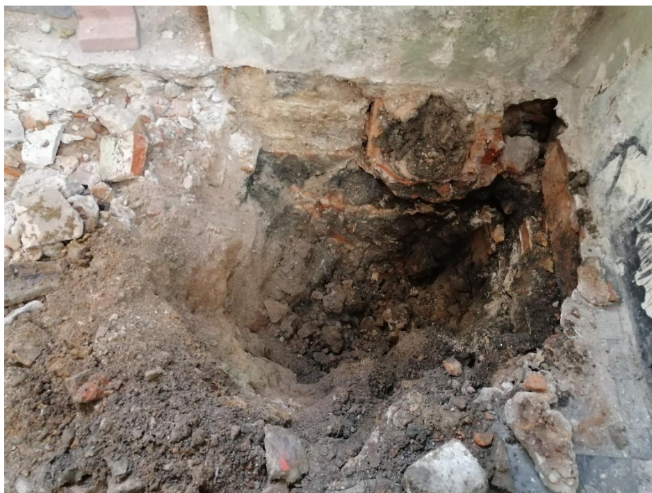
Fig. 10. Fotografia final dels treballs de rebaix 1 . Font: Imatge pròpia.
