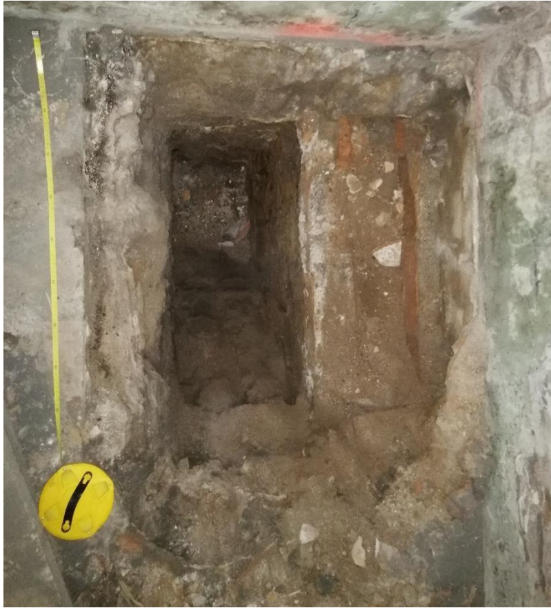
Fig.16. Fotografia del final dels treballs de rebaix. Font: Imatge pròpia.
