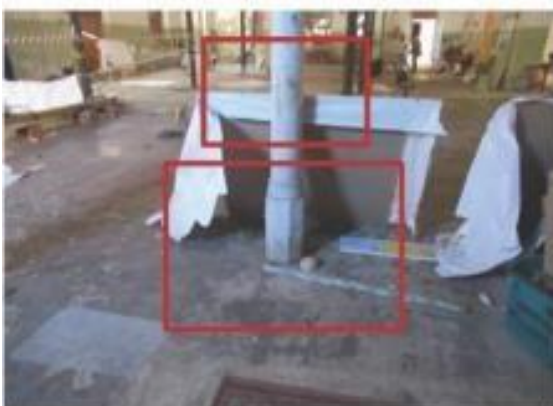
Imatge 5: CC-PB_05 en fonaments i CPF-PB_02 en pilar de fosa
