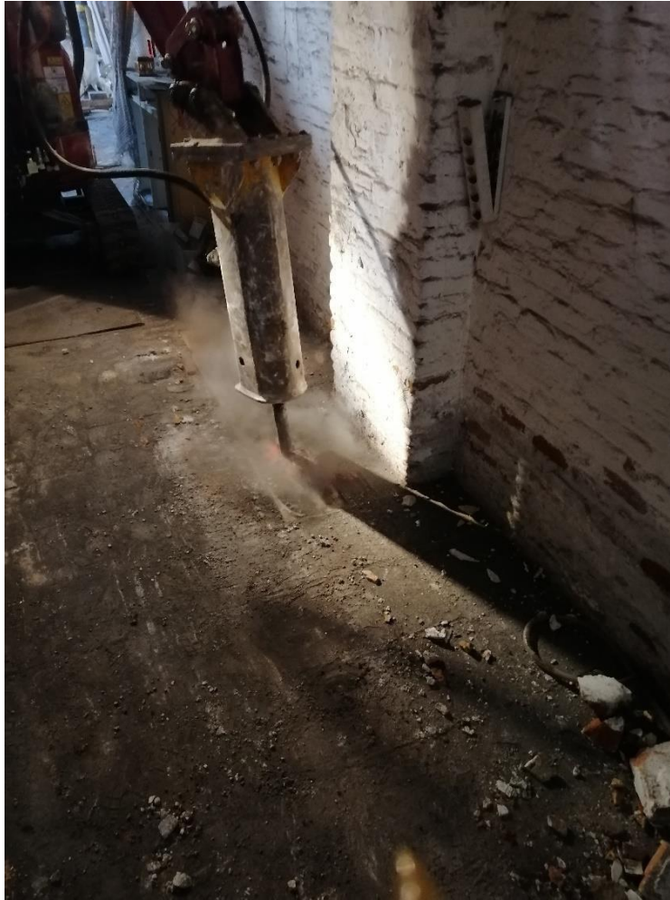
Fig.13. Fotografia de l'inici dels treballs. Font: Imatge pròpia.
