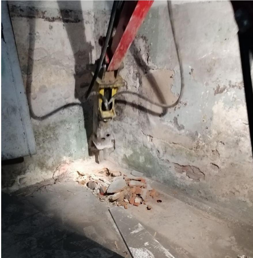
Fig.15. Fotografia de l'inici dels treballs de rebaix. Font: Imatge pròpia.
